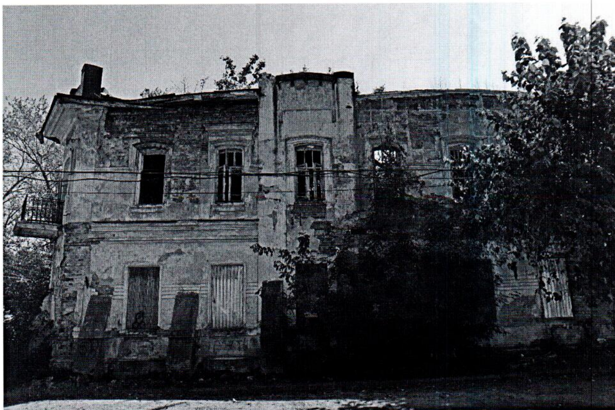
Точка фотофиксации № 8. Фрагмент северо-западного фасада.
