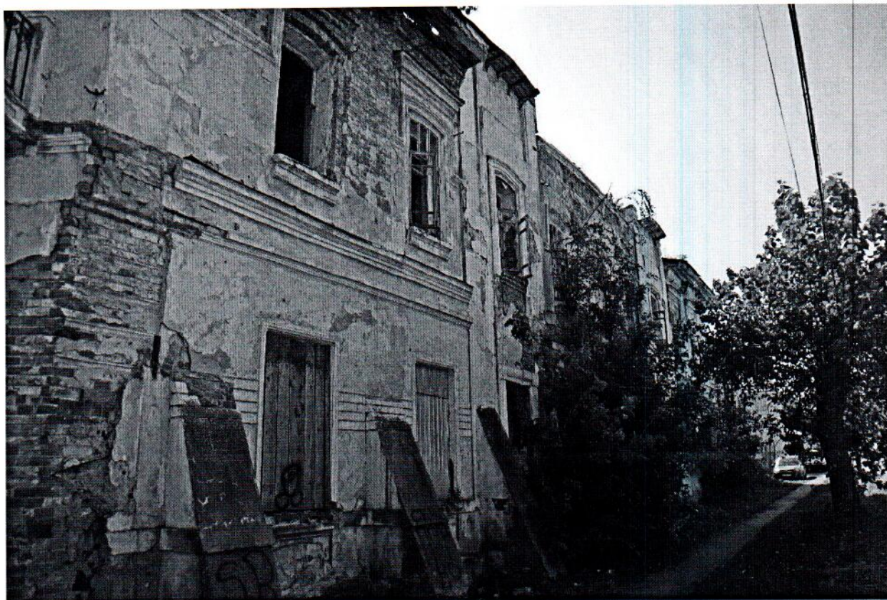
Точка фотофиксации № 7. Фрагмент северо-западного фасада.
