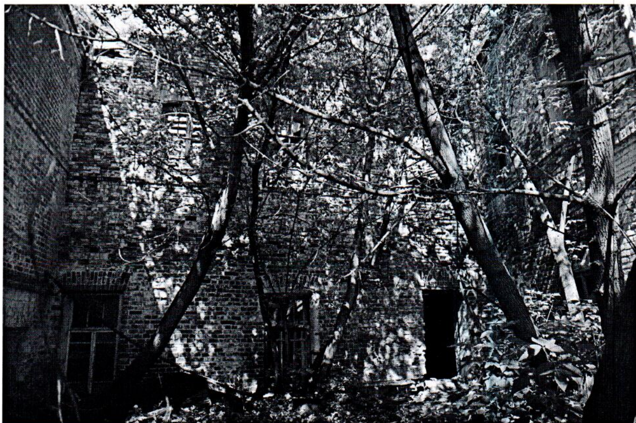
Точка фотофиксации № 14. Фрагмент юго-восточного фасада.
