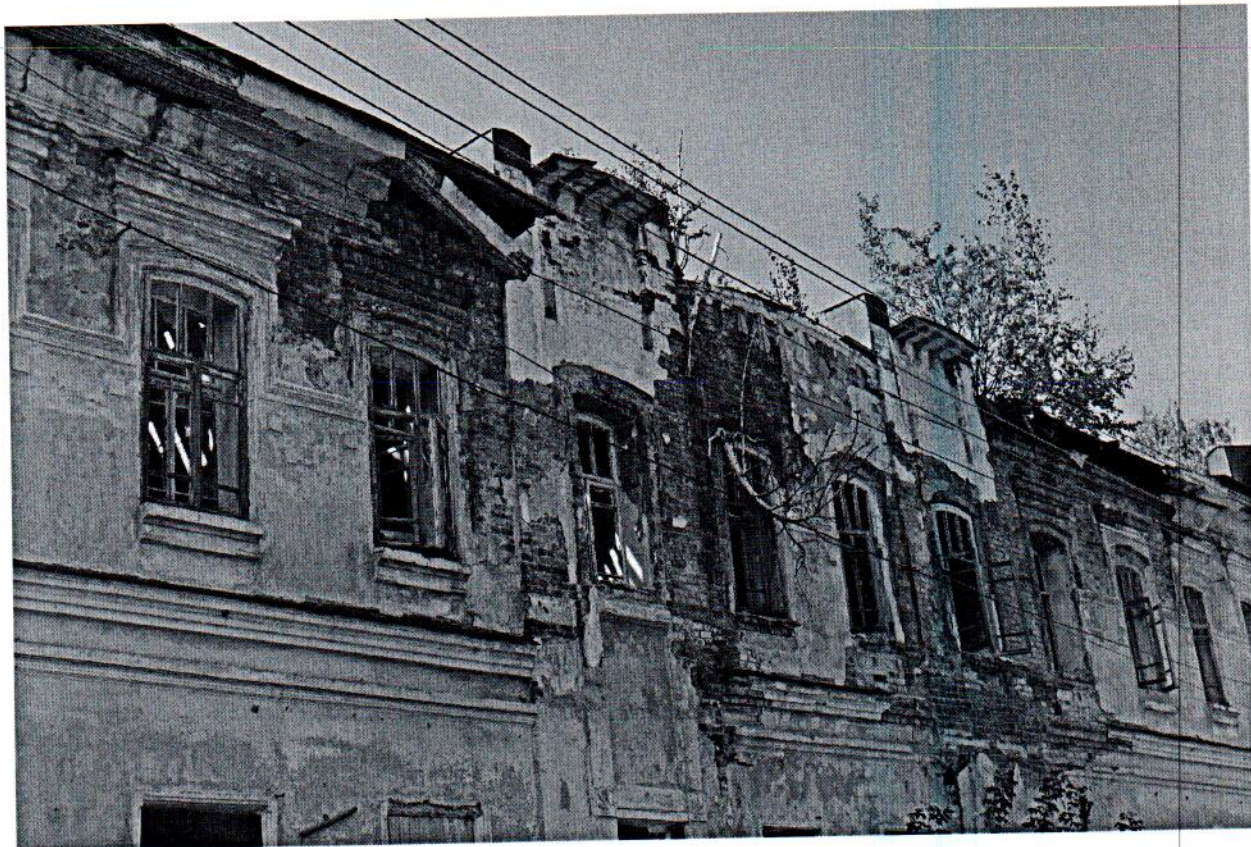
Точка фотофиксации № 4. Фрагмент восточного фасада.
