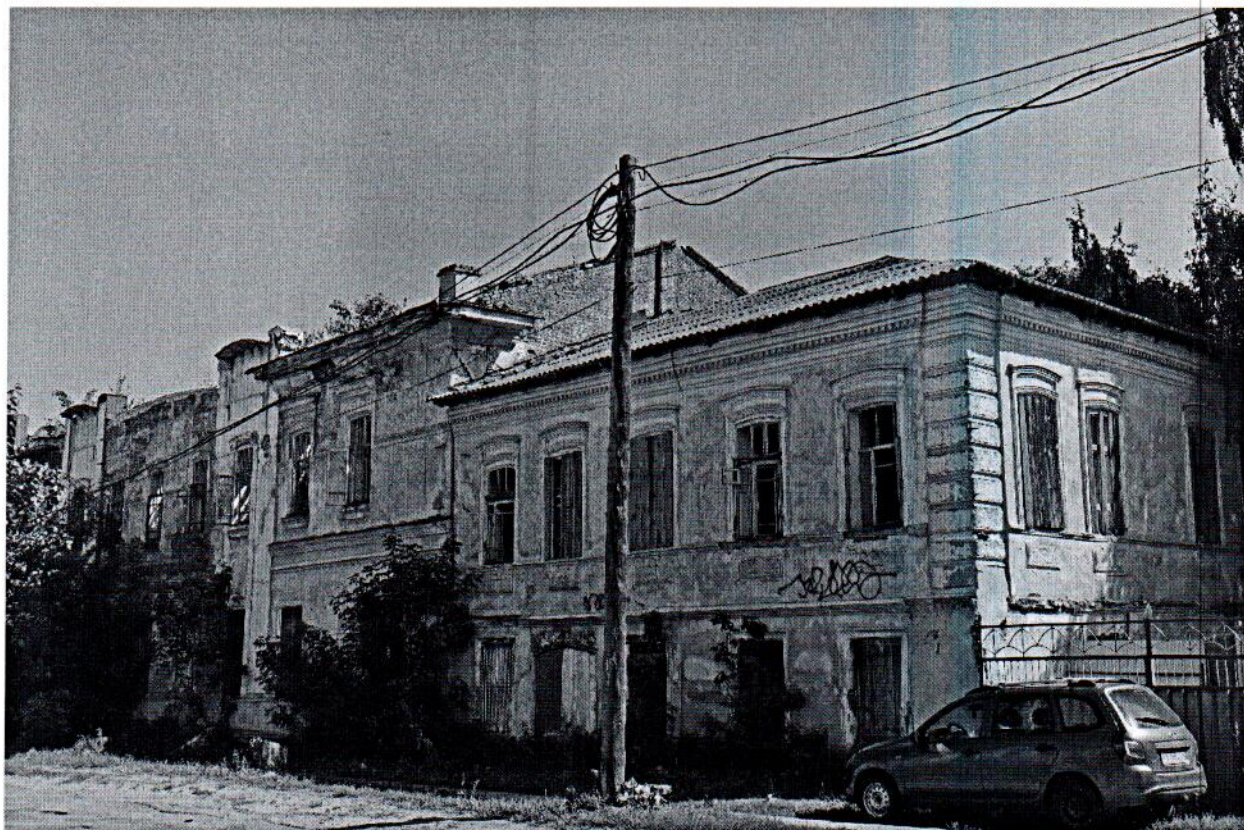
Точка фотофиксации № 10. Общий вид с северо-западной стороны.
