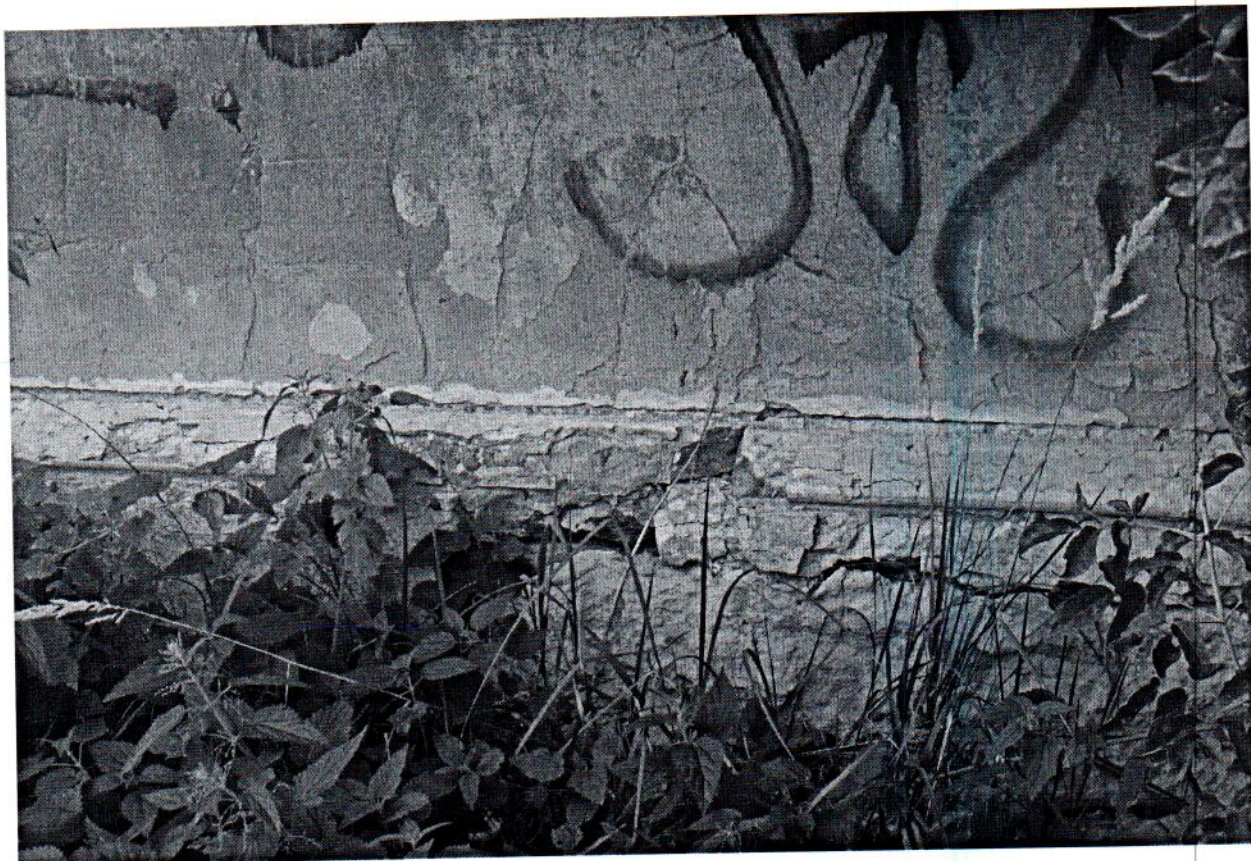
Точка фотофиксации № 3. Фрагмент восточного фасада.
