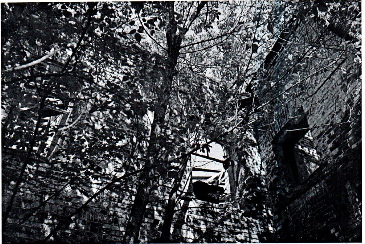
Точка фотофиксации № 15. Фрагмент юго-восточного фасада.
