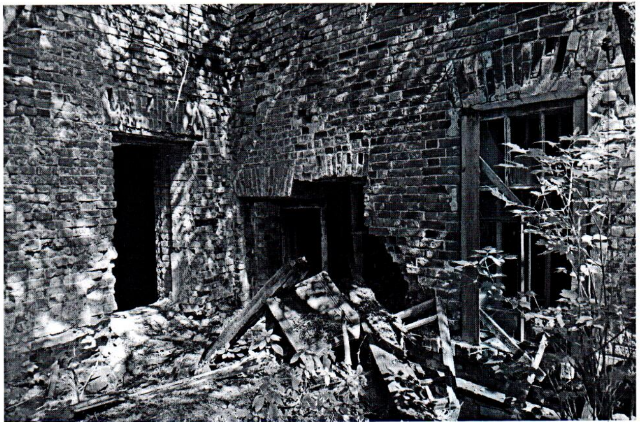
Точка фотофиксации № 16. Фрагмент западного фасада.
